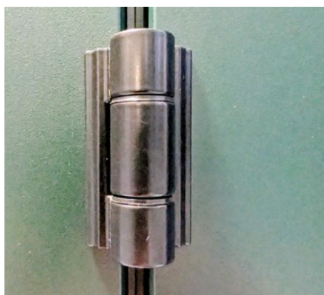
DETTAGLIO CERNIERA A SCOMPARSA.
